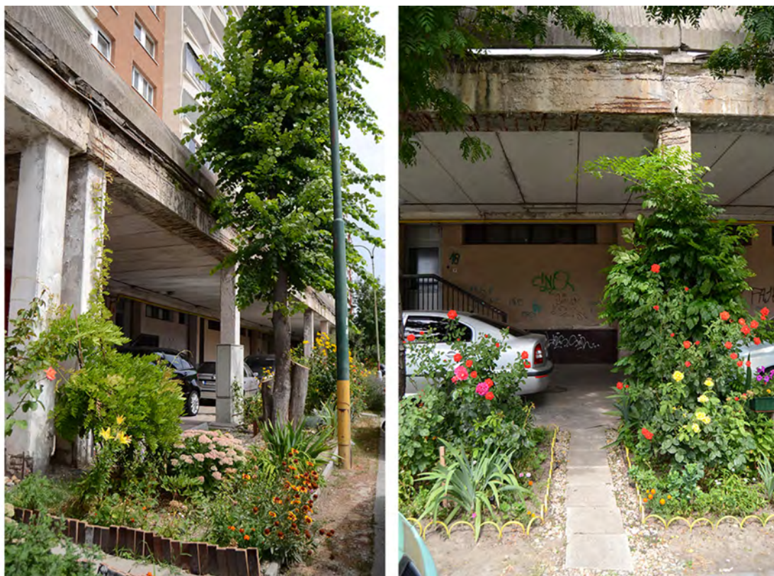
Obr. 4: Predzáhradka pod terasou bytového domu na Jungmannovej ulici v Petržalke.
