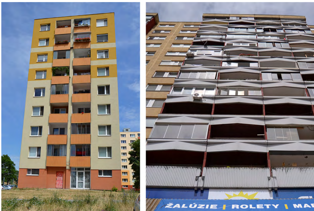
Obr. 2: Balkóny zatepleného bytového domu v Petržalke a lodžie na type terasového bytového domu.
