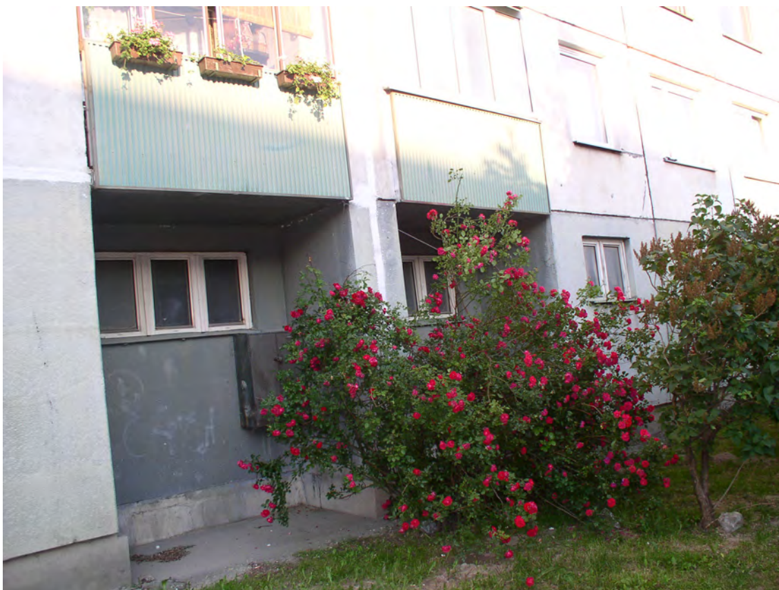
Obr. 5: Úprava balkóna a predzáhradky pred oknom panelového bytového domu, Petržalka.
