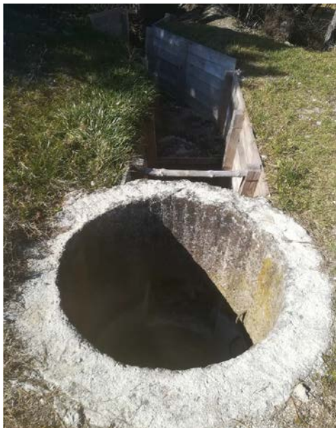
Obr. č. 3: Zrekonštruovaný obranný objekt Wehrmachtu pri Trstine. Foto: T. Tkáčik
