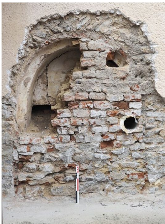
▲ Obr. 6. Odkrytý románsky portál južnej fasády lode. Foto M. Bóna.
