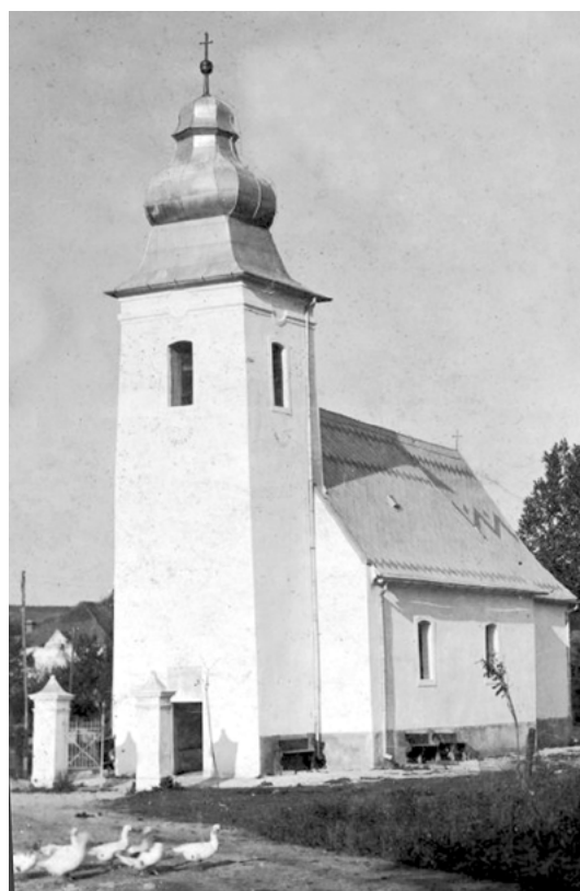
▲ Obr. 2. Kostol od juhozápadu na fotografii z 20. rokov 20. storočia (Archív Obú Jelenec). Fig. 2. Church from the southwest on the photo from the 1920s (archive of Jelenec municipality)
