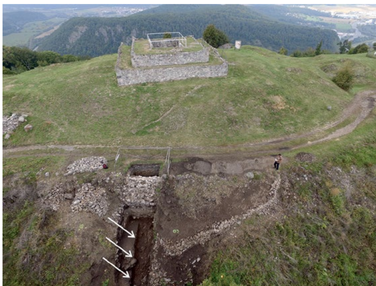
▲ Obr. 10. Horný Pustý hrad. Deštrukcia po valovej kamienno-zemnej konštrukcii z neskoršej doby bronzovej objavená v sonde 1/2017 (foto: J. Beljak).
