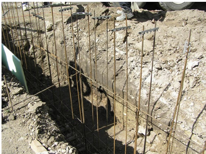
▲ Obr. 5. Interiérový plot 2 pripravený na betonáž. Ryha vystužená roxormi. Foto: J.Schmidtová.
