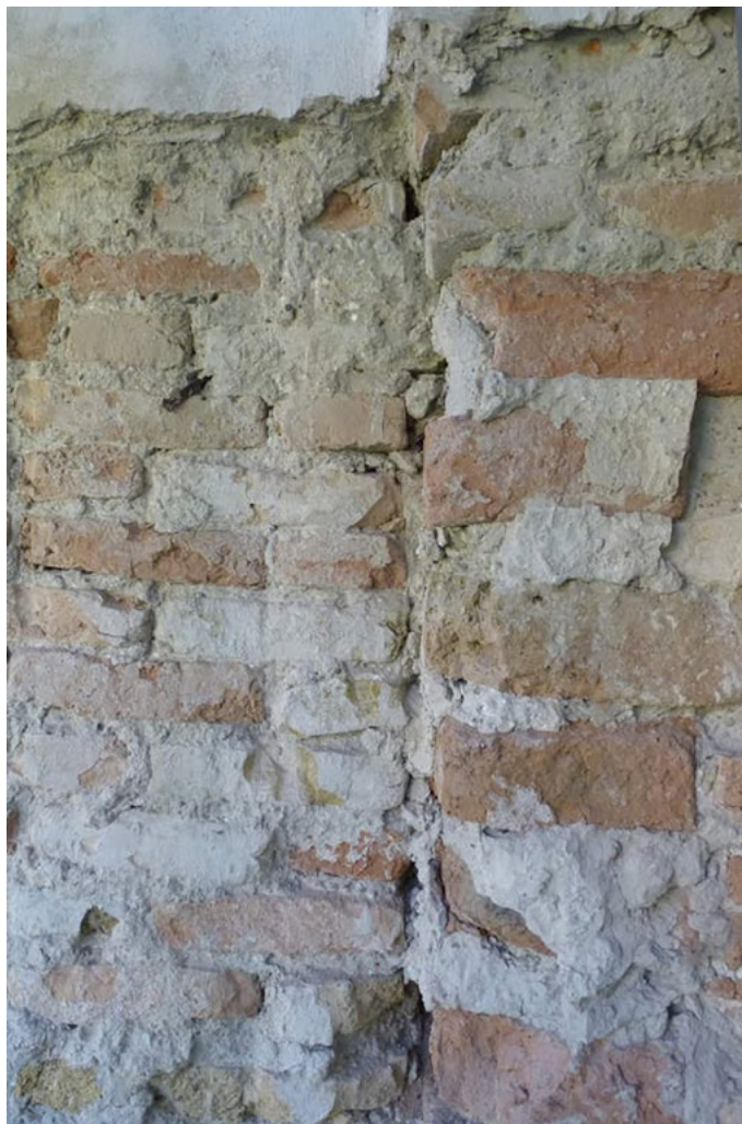
▲ Obr. 13. Šamorínsky kostol – Severozápadné nárožie veže (vpravo), vybudované v spodnej časti z veľkých plevových armovacích tehál rozmeru 10 x 20 x 34–36 cm. Foto: P. Paulíny.
