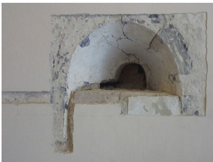
▲ Obr. 18. Podunajské Biskupice – kostol – horné ukončenie okna II. etapy - t. č. južná stena organového chóru. Foto: P. Pauliny.
