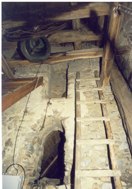
▲ Obr. 5. Okná východnej steny 4. a 5. podlažia veže. Foto M. Bóna.
