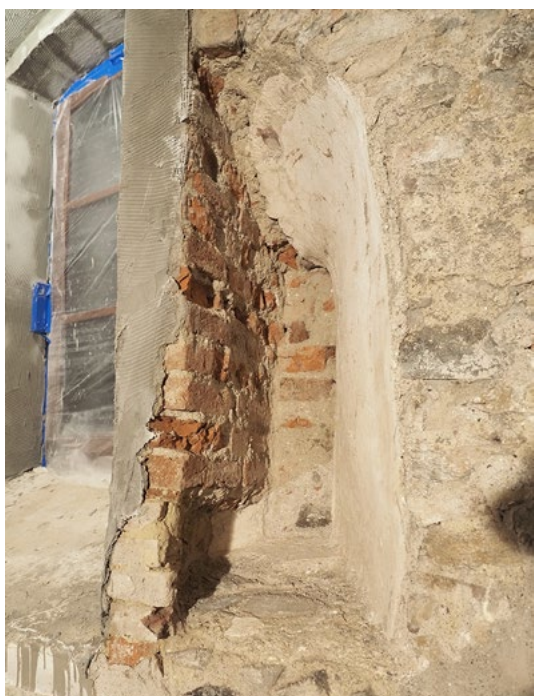
▲ Obr. 7. Odkrytá časť románskeho okna južnej steny lode. Foto M. Bóna.
