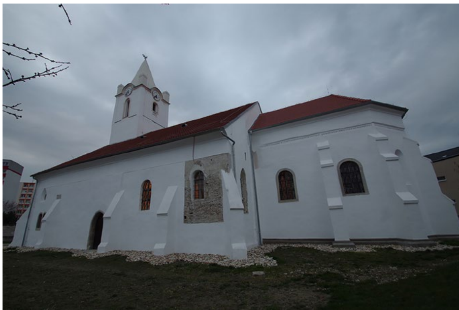
▲ Obr. 1. Šamorínsky kostol po obnove – pohľad z juhovýchodu. Foto: P. Pauliny.
